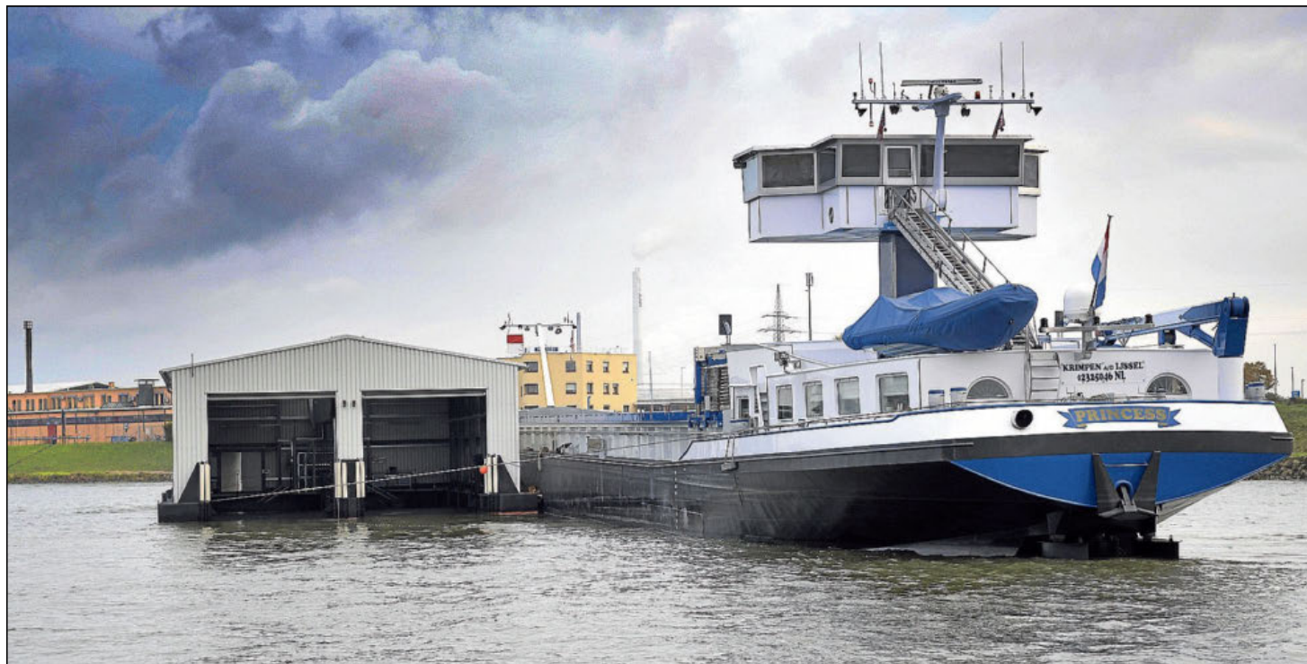
Die neue Bootshalle der Mannheimer Wasserschutzpolizei (l.) kann zwei Boote mit einer Länge von 20 Metern aufnehmen. Foto: Gerold
